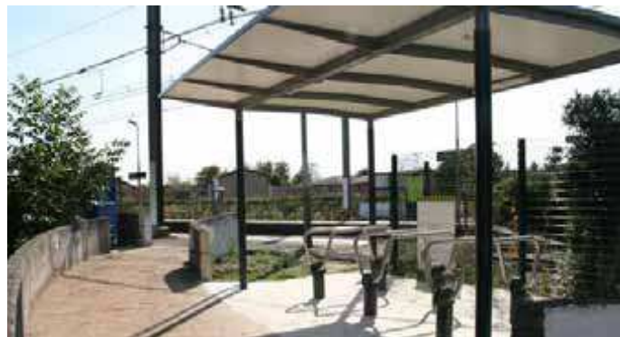
Halte ferroviaire de Labège (31) avec un abri vélo
