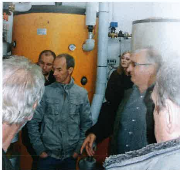
visite d'un projet de rénovation d'une chaudière
