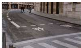
Sas pour cyclistes aux carrefours à feu Source : www.ffct.org
